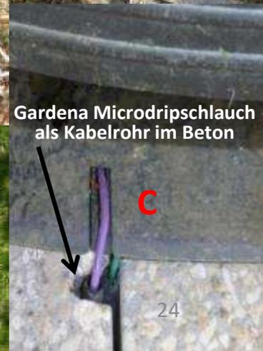
Gardena Microdripschlauch als Kabelrohr im Beton
