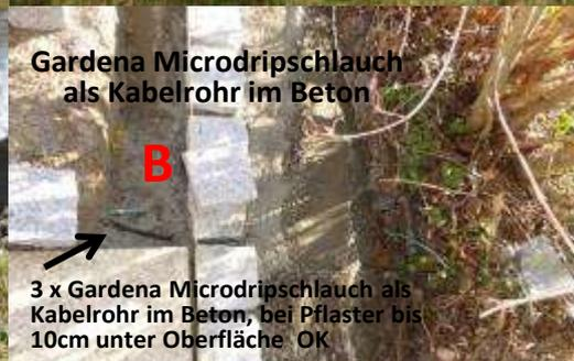
Gardena Microdripschlauch als Kabelrohr im Beton
