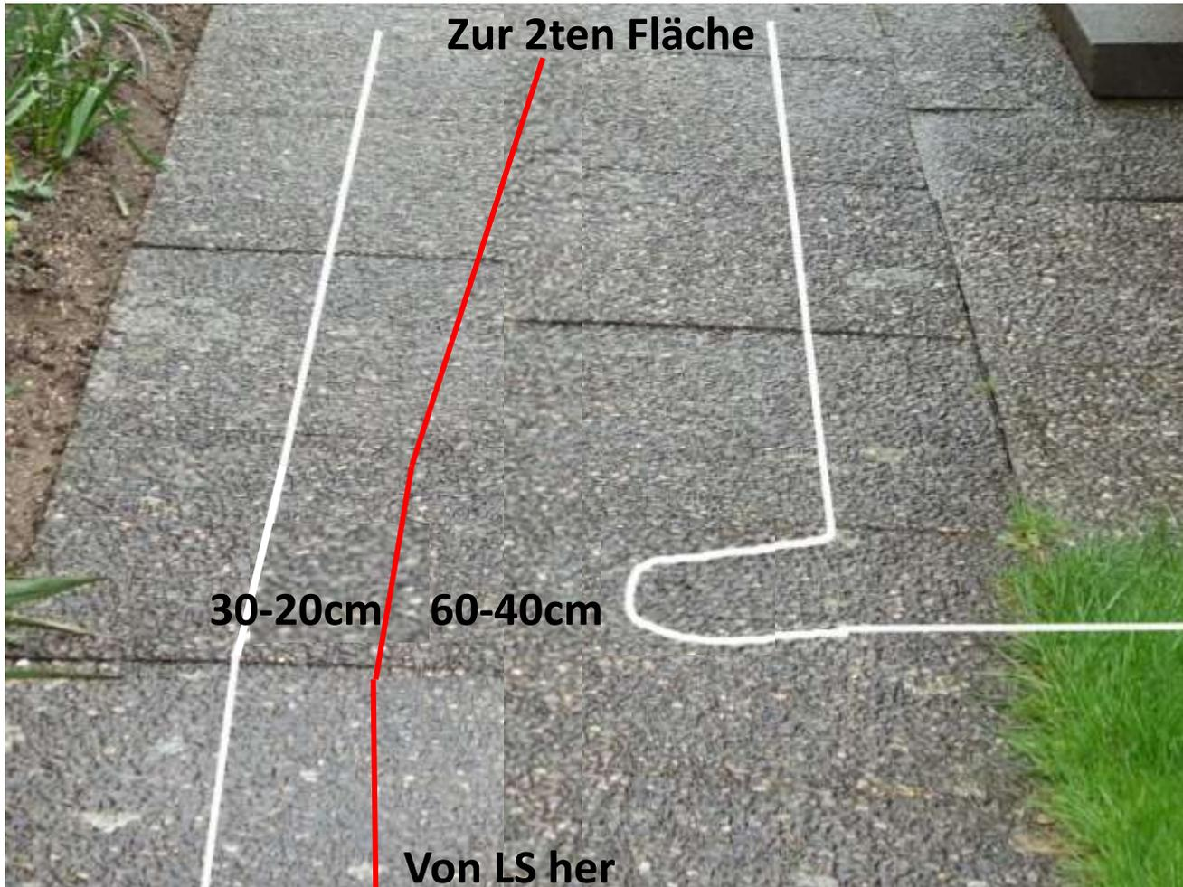
Gleich wie vorher aber die Kabelverlegung in der Passage asymmetrisch gestalten damit mit Korridor mittel gefahren werden kann.
