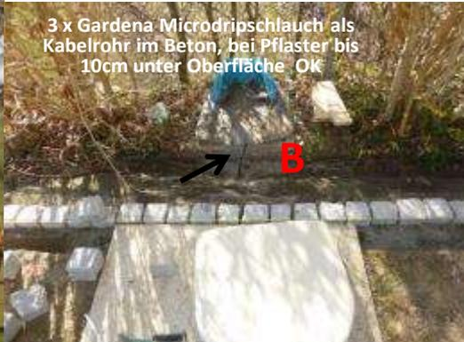
3 x Gardena Microdripschlauch als Kabelrohr im Beton, bei Pflaster bis 10cm unter Oberfläche OK
