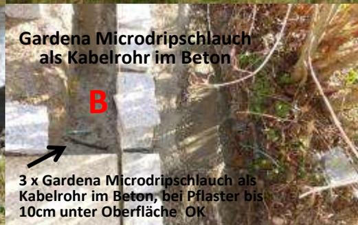
Gardena Microdripschlauch als Kabelrohr im Beton
