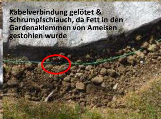
Kabelverbindung gelötet & Schrumpfschlauch, da Fett in den Gardena Klemmen von Ameisen gestohlen wurde
