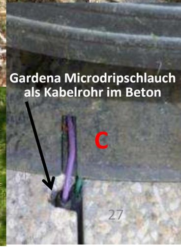
Gardena Microdripschlauch als Kabelrohr im Beton
